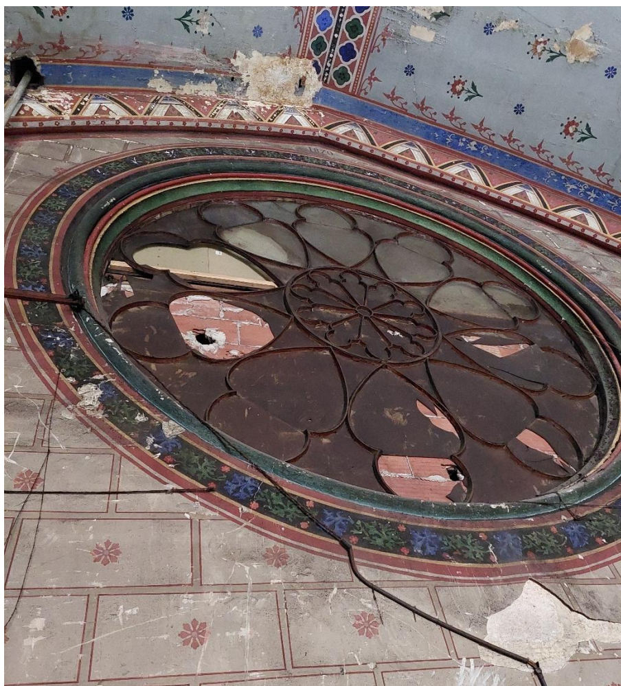
Rose Ouest bouchée en brique
