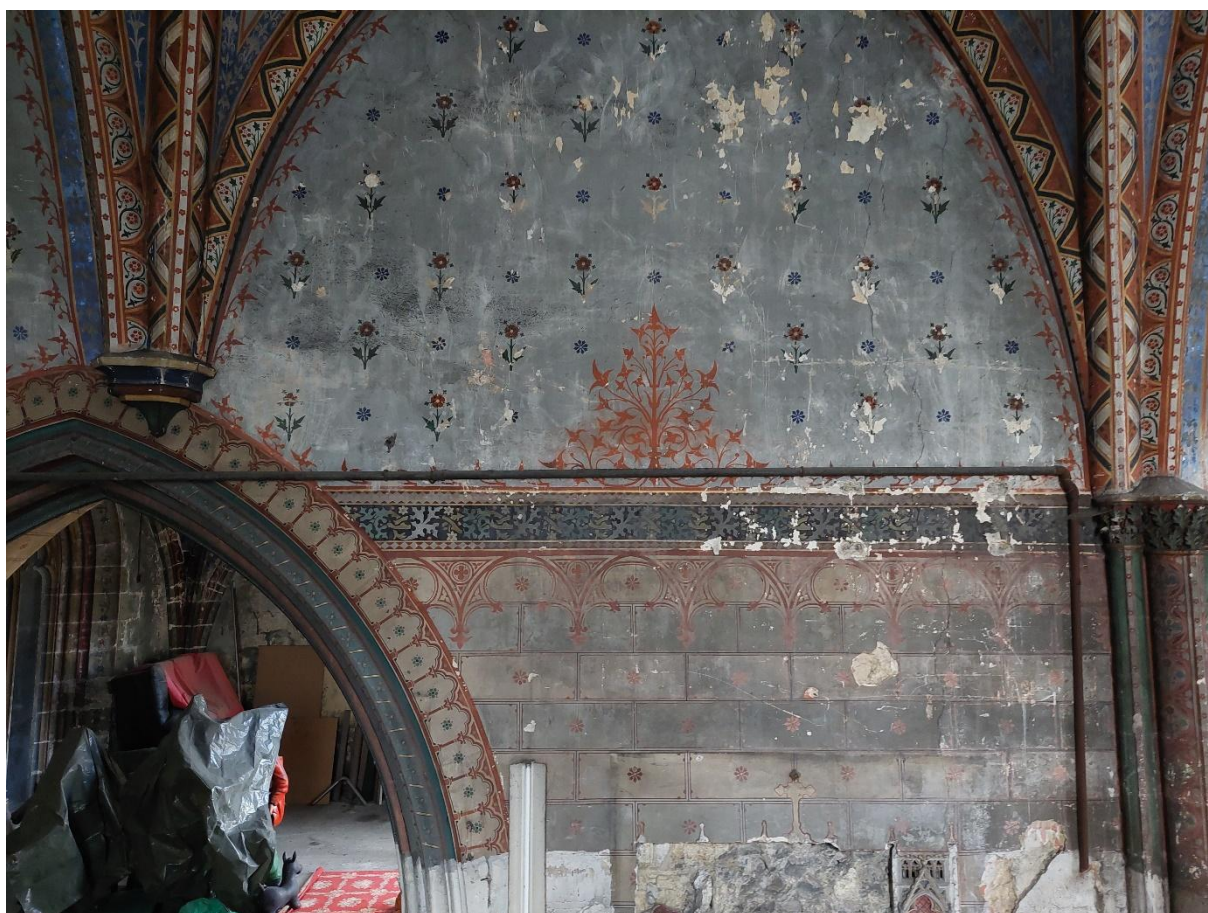
Décor inférieur antérieur au décor supérieur des voûtes. Amortissement des nervures de la croisée sur l'arc donnant sur la chapelle Nord.
