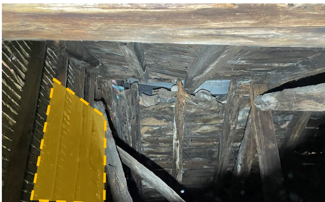
À gauche la paroi du puit de lumière dans laquelle sera réalisée une ouverture. Au centre la panne faîtière manquante.
